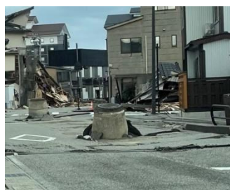
能登半島地震での 下水道被害の様子（輪島市）
